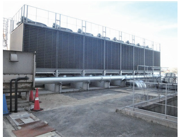
排水配管、給水主管を設置した状態
