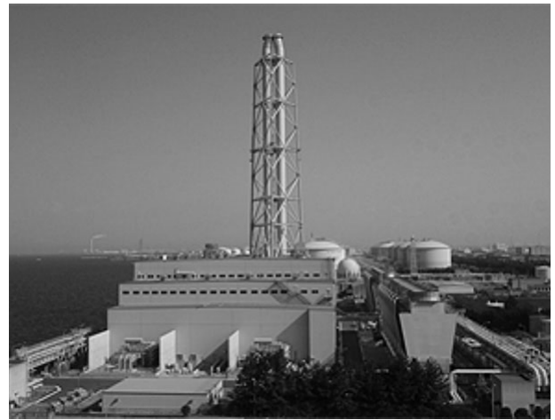
天然ガス発電所
