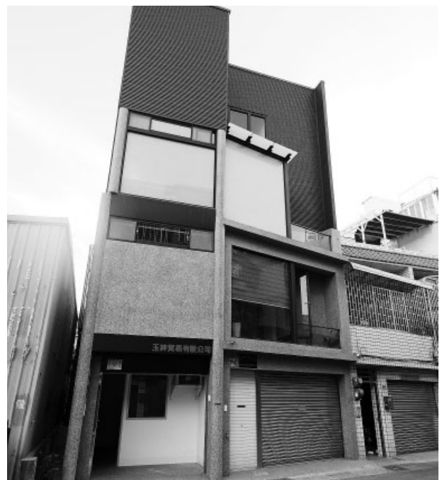
2013年5月完成の新社屋
