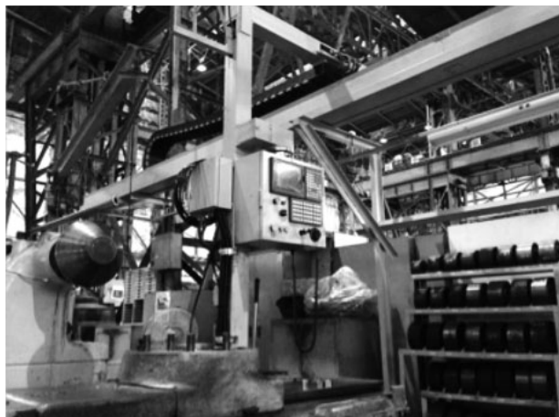
立ち上げたアームを頭上後方のケーブルベアに接続
