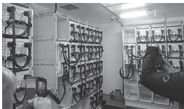
LNGフェリー内のバッテリーセル (今後増設していくとのこと)
