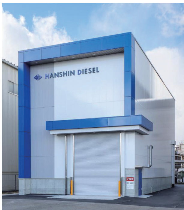
新運転設備（高度研究棟）
